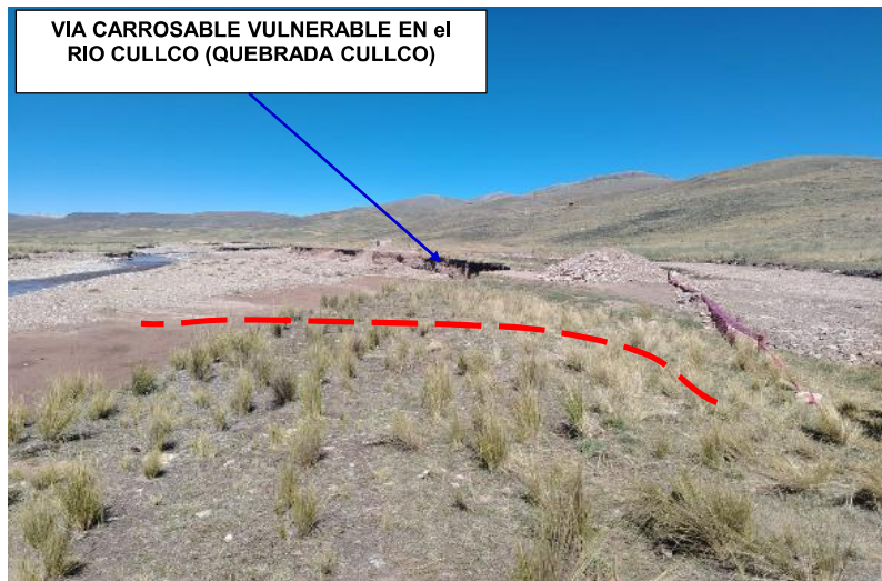
FIGURA N°01: TRAMO CRÍTICO EN EL RIO CULLCO (QUEBRADA CULLCO), SE EVIDENCIA SOCABACION SEVERA, EN EL CENTRO POBLADO BELEN, DISTRITO DE POTONI, PROVINCIA DE AZANGARO - PUNO.
